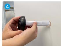
Pase los tornillos y el cable a través de la puerta. Se puede ayudar con un papel enrollado.
